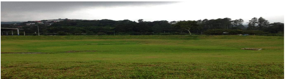
I etapa de construcción
